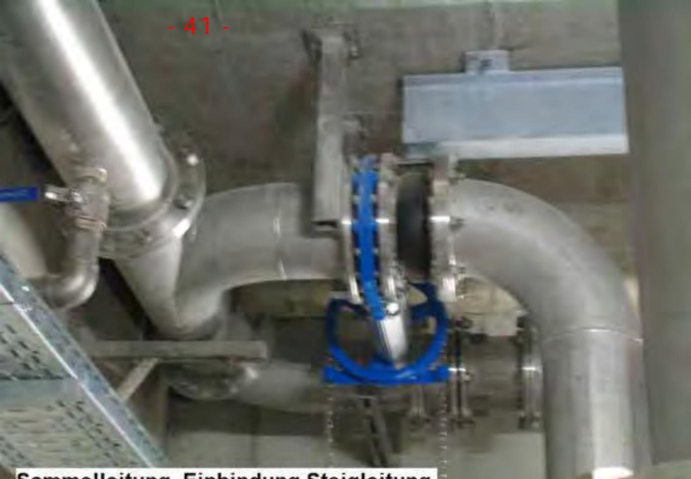
**Sammelleitung, Einbindung Steigleitung**
