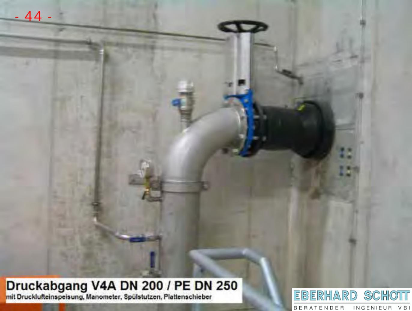
**Druckabgang V4A DN 200 / PE DN 250**
